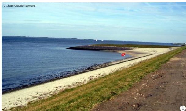
Photo 1 : Digue de Wemeldinge, côté gauche des Tetjes
